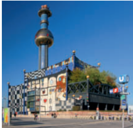
Die Spittelau wird dieses Jahr modernisiert und noch umweltfreundlicher.
